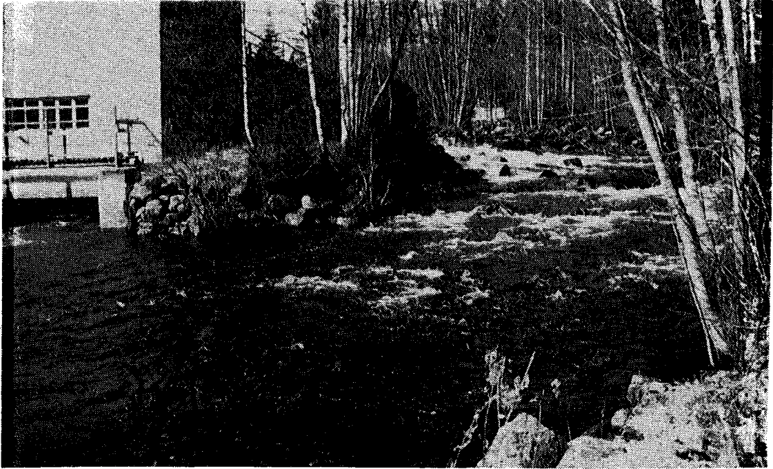
Kuva 24. Kärnänkosken kalatien luonnonmukainen koskiosuus tulva-aikana (Laine ym. 1991a).
