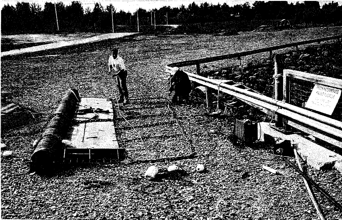
Kuva 28. Ohjainaidan rakenne (kuva: Anne Laine, Oulun yliopisto)
