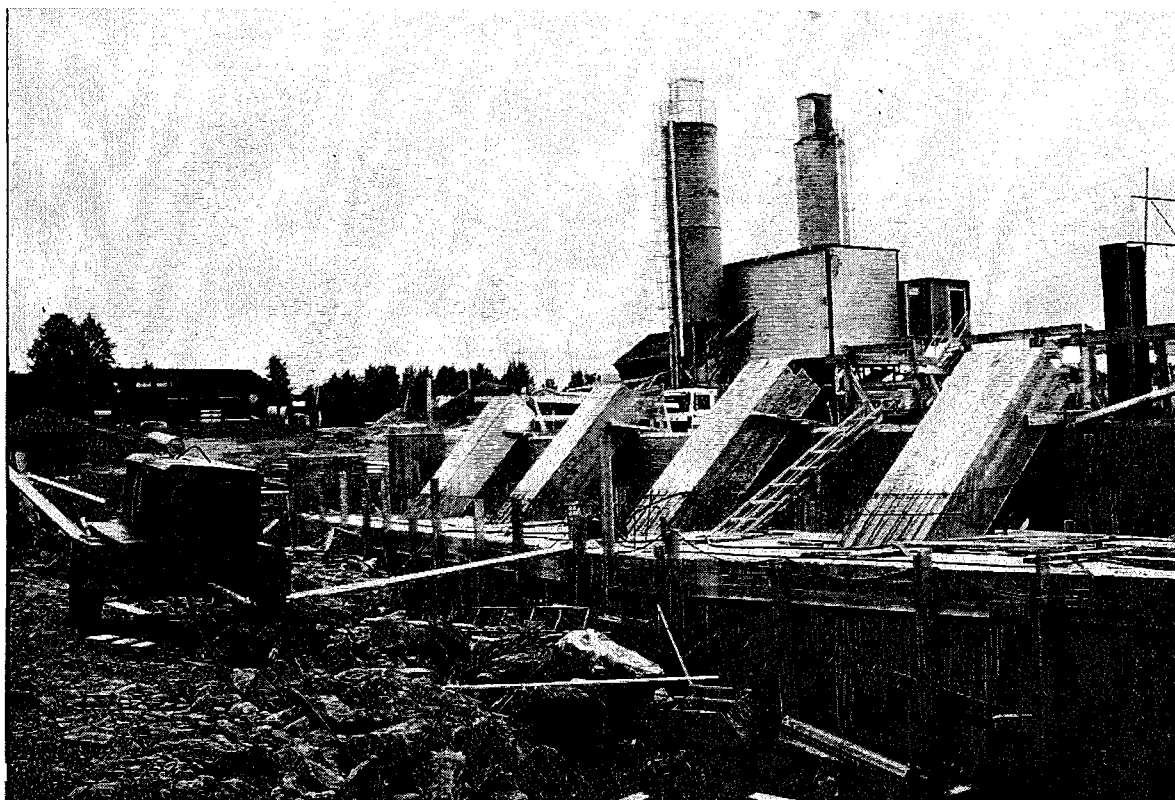
Kuva 15. Eteläisen sisäänkäynnin tunneliosuudelle on järjestetty luonnonvaloa kaltevien valokuilujen avulla (kuva: Aapo Mäenpää, Keminmaan kunta)
