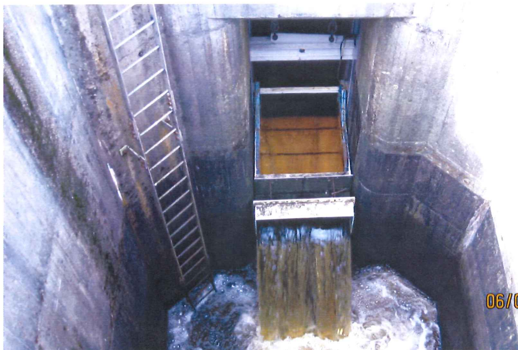
Kuva 8. Torr Achilty laitoksen Borland kalatien sulutusammion täyttö meneillään. Kalalaskuri on myös näkyvillä.
