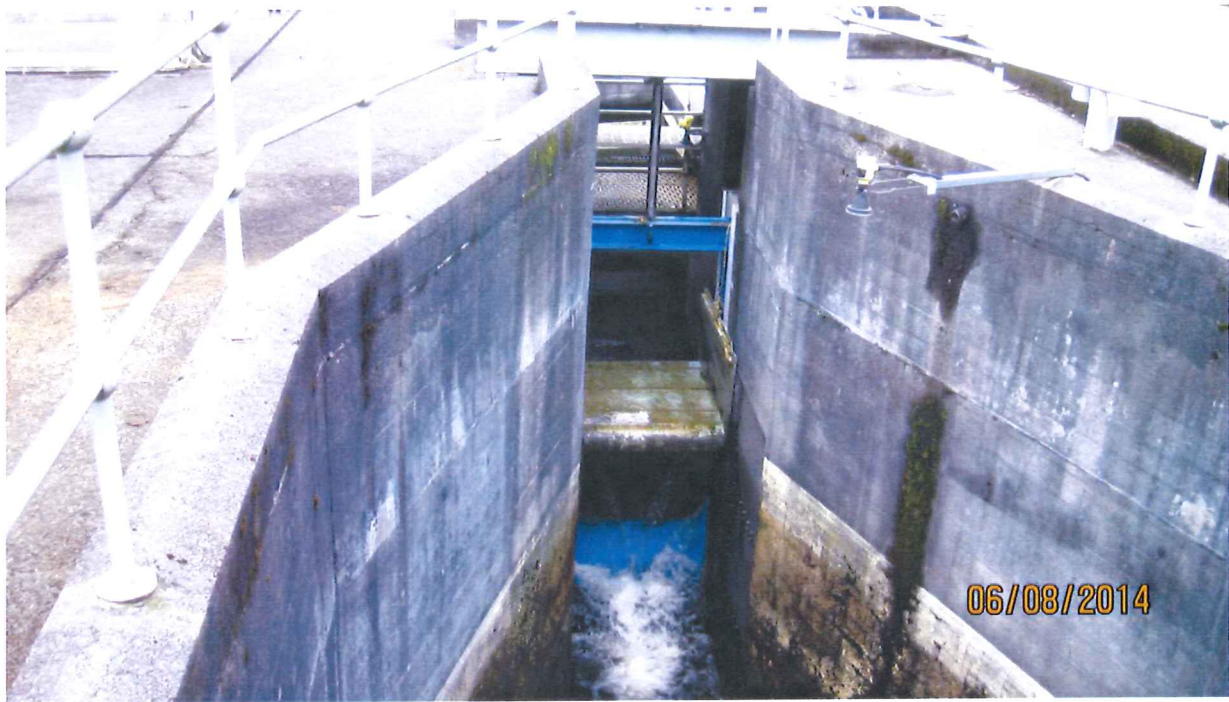
Kuva 7. Kilmoracin kalatien kalalaskuri on kuvassa keskellä. Laskuri sijaitsee kalatien ulosmenoväylän alkupäässä, sulutuskammion yläosassa.
