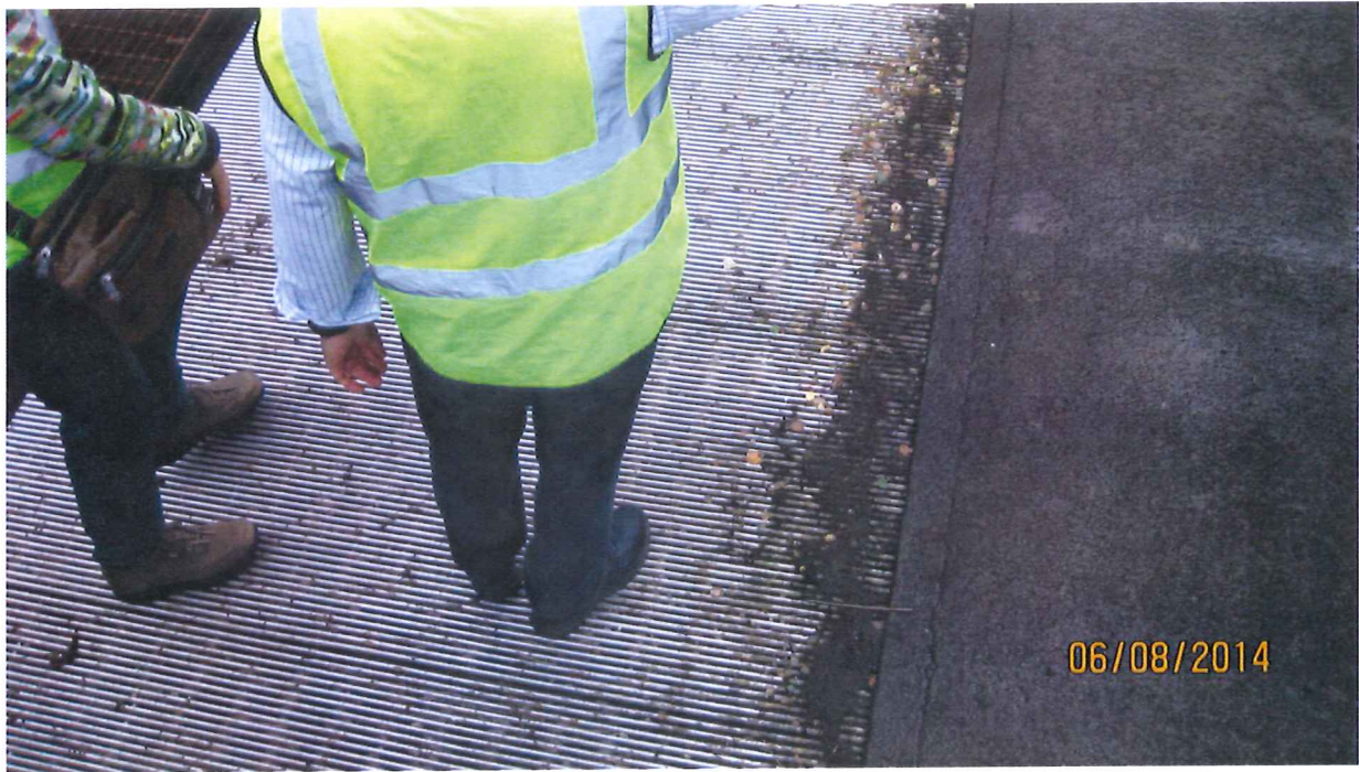
Kuva 11. Achanaltin padon smolttipyydyksen loppuosa. Vesi putoaa ritilöiden välistä uomaan ja smoltit jäävät ritilöiden päälle ja vierivät kouruun, joka johtaa smolttien keräilyaltaaseen. Altaasta smoltit siirretään tankkiautoon ja autolla merelle.
