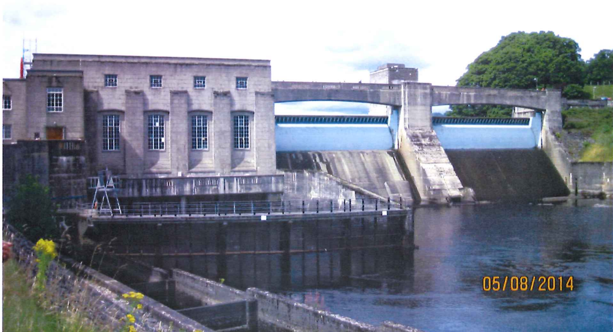
Kuva 3. Pitlochryn vesivoimalaitos valuma-alue 1,600 \text{ km}^2 , keskivirtaama 75 \text{ m}^3 , padon korkeus 15m teho 15MW. Kuvan vasemmassa alareunassa kulkee pystyrakokalatatie. Turbiinivesien ulostuloaukkojen edessä on kalojen ohjainaita kalatien suulle.
