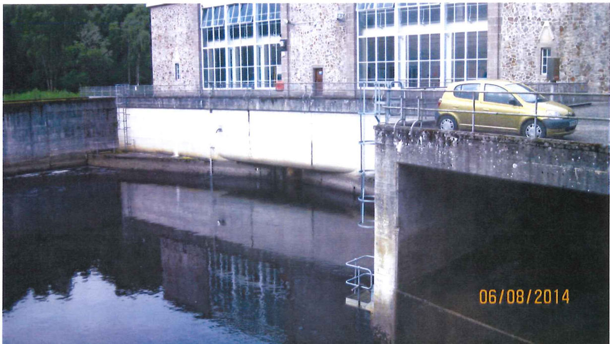
Kuva 6. Kilmorackin voimalaitoksen Borland – kalatien suuaukko kuvassa keskellä.
