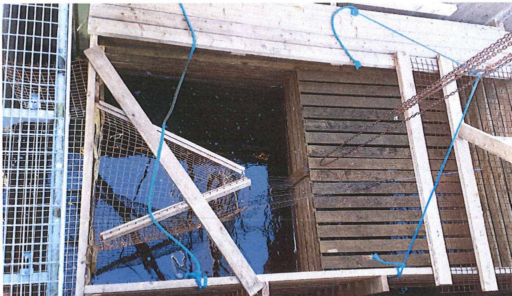
Vanhan kalatien pohjoisen sisäänkäynnin pyyntilaitte
