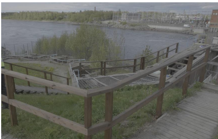
Kuva Kalatien työtason, yleisötilan kaiteiden uusiminen
